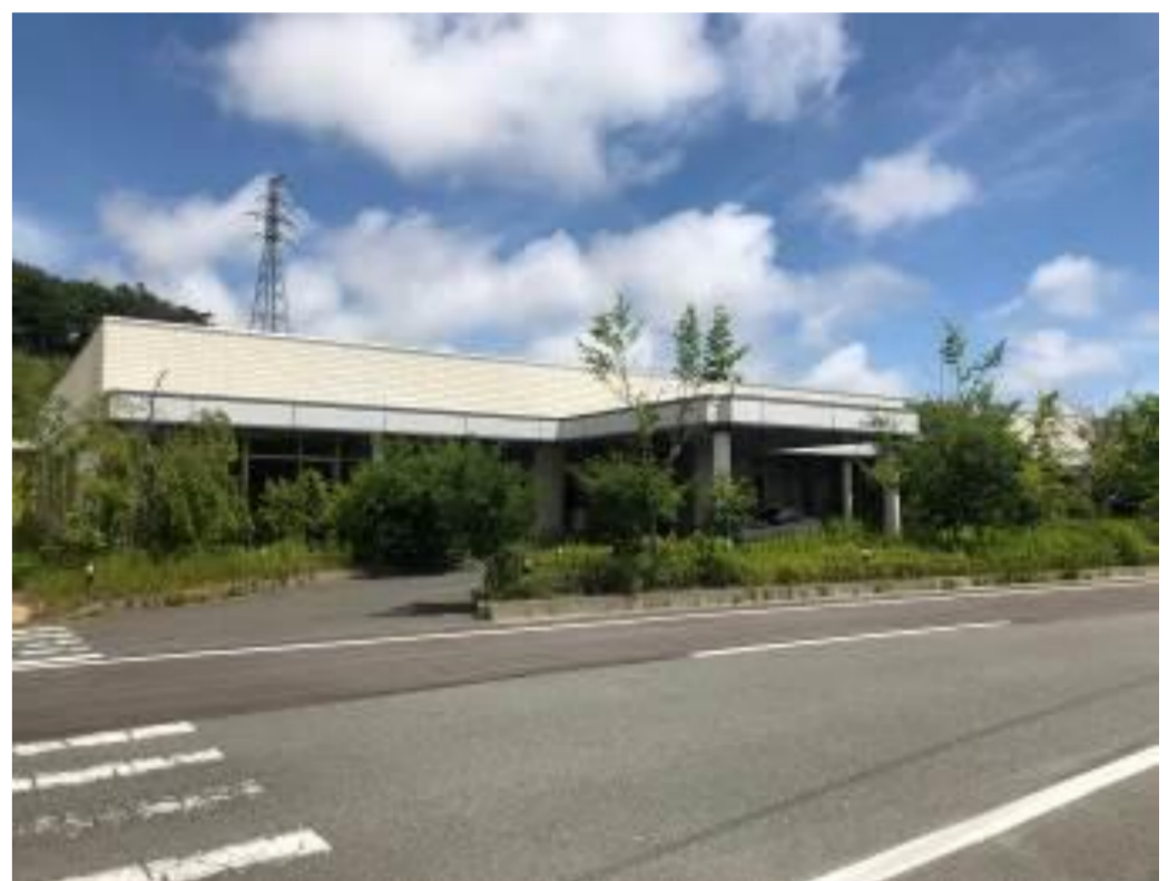
現地施設の予定地 (将来) (浪江町藤橋産業団地の建屋)
